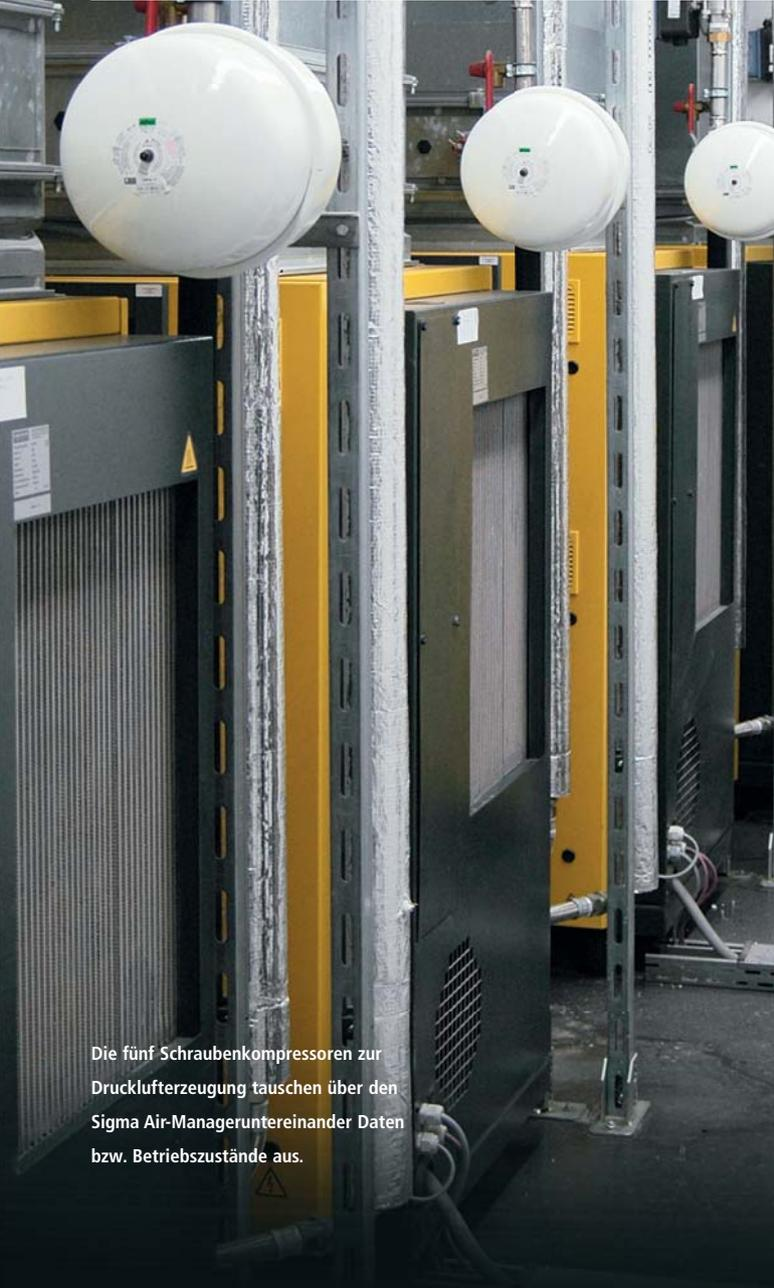
Die fünf Schraubenkompressoren zur Druckluftherzeugung tauschen über den Sigma Air-Manager untereinander Daten bzw. Betriebszustände aus.
