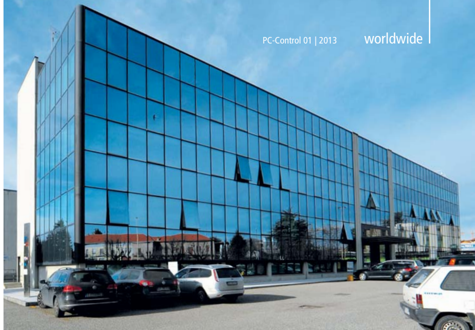
Im zweiten Quartal 2013 bezieht die Firmenzentrale von Beckhoff Italien ihren neuen Sitz in Limbiate, zehn Kilometer nördlich von Mailand. Das 900 Quadratmeter große Büro gibt Raum für zukünftige personelle Entwicklungen.
